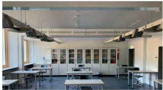
*Einbau im Deckenkoffer. Dieser Einbau ist nur durch die hoch-induktiven Schlitzdurchlässe zugfrei realisierbar.*
