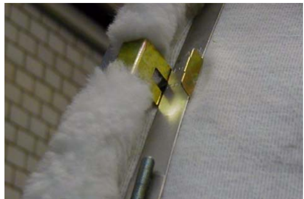
Klammern zur Befestigung des Filtermediums
