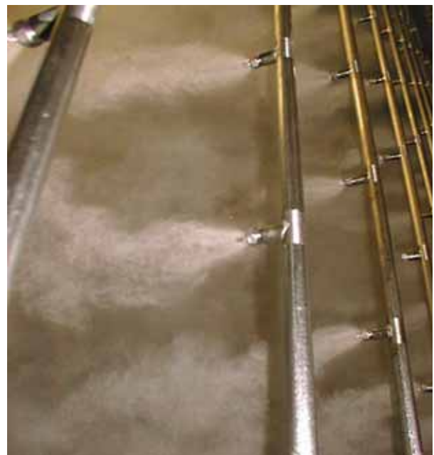
Sprühbild der Hochdruckdüsen
