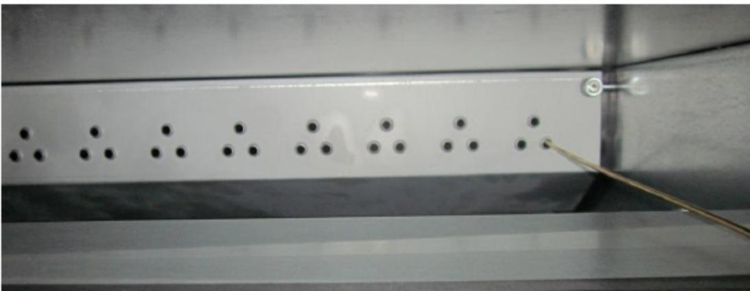
Abbildung 6 Messung des Düsendrucks im Düsenkasten
