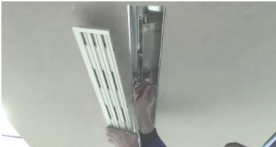
Kondensatwanne, Filter und Schalldämpfer sind nach Entfernen des Schlitzauslasses leicht zugänglich. (Bild: LTG)
