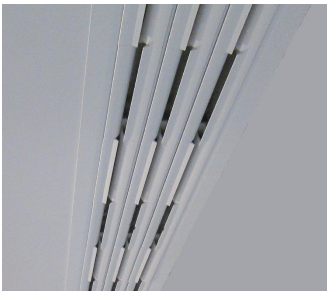
Schlitzauslass des Deckengeräts „VKL SystemIndivent“
