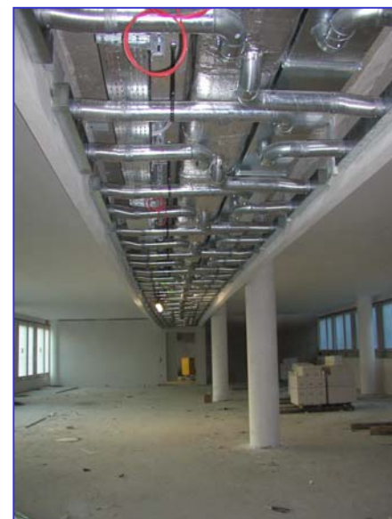
Bild 2 (rechts): Beispiel einer Lüftungsmontage im Deckenkoffer
