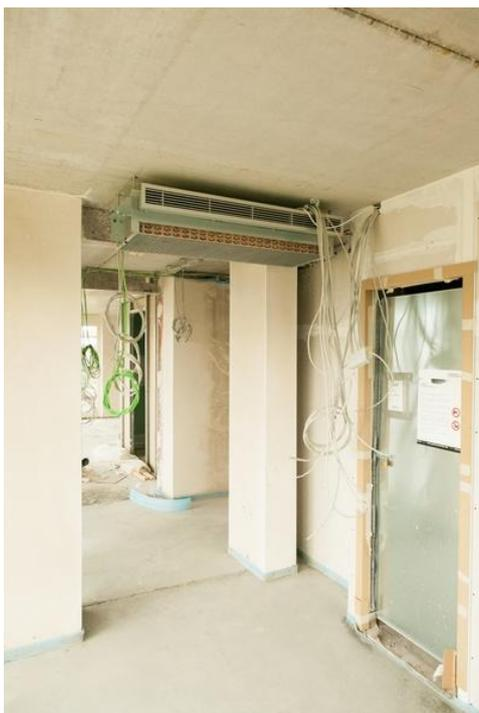
*Die Induktionsgeräte werden an den Zimmerdecken montiert, bevor der eigentliche Innenausbau beginnt.*
