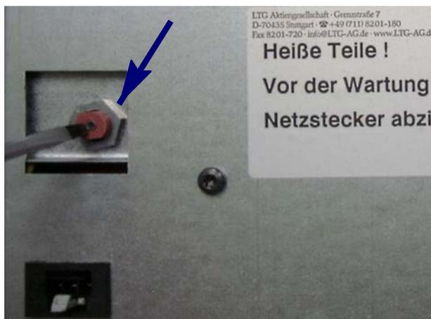
Lost der STB aus, muss das HFF-Gerät abgeschaltet und von Elektrofachpersonal eine vollständige Funktionsprüfung durchgeführt werden.
