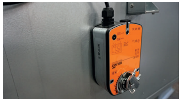
Stellantrieb für die Außenluft-/Sekundärluftklappe
