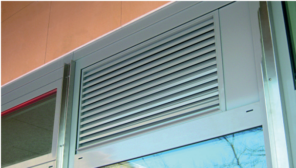
Außenansicht Wetterschutzgitter von LTG
